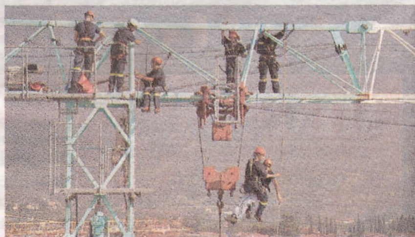
I pompieri occupati nel salvataggio di un ferito su una gru da cantiere
